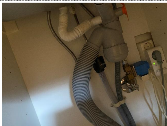
Bilde nr. 21 Nyere røropplegg på kjøkken i boenhet i trehus
