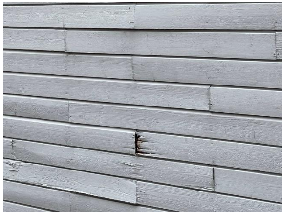
Bilde nr. 3 Utskifting av kledning med råte på småhus og forbedre avslutning mot bakken, ny overflatebehandling enkelte steder.
