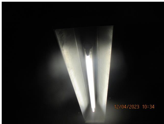
Bilde nr. 45 Garasjelys bør skiftes til led-lys med moderne lysstyring.
