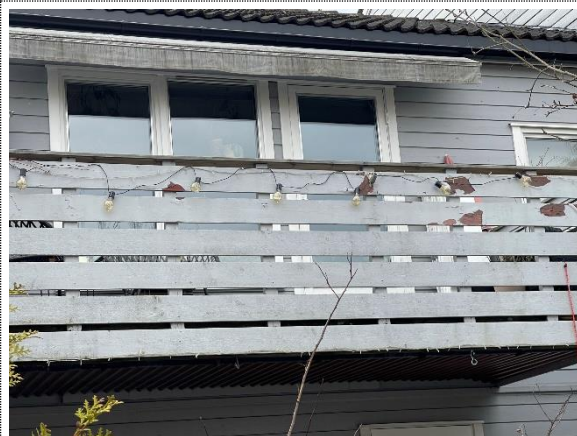
Bilde nr. 16 Ny overflatebehandling av balkonger og utbedring av platene under balkonger.
