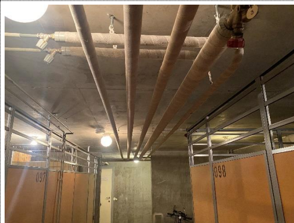
Bilde nr. 22 Vannrør i kjeller
