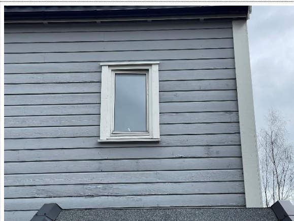
Bilde nr. 9 Utskifting av vinduer, balkongdører og inngangsdører.
