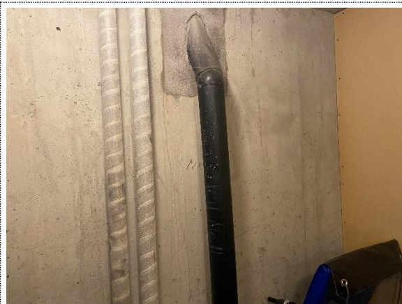
Bilde nr. 26 Plast avløpsrør i 1. etg i blokk
