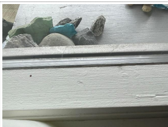
Bilde nr. 7 Utskifting av vinduer, balkongdører og inngangsdører.
