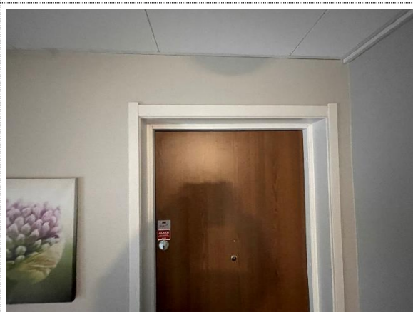
Bilde nr. 11 Utskifting av samtlige dører i blokkene.
