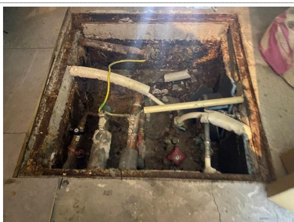
Bilde nr. 29 Kulvert med luke i gulv i gang i boenhet i u.etg trehus
