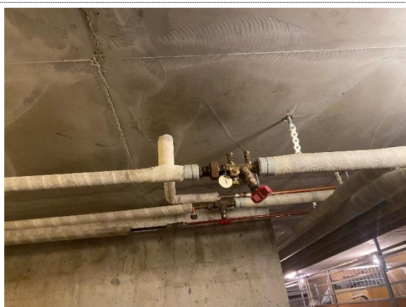
Bilde nr. 23 Vannrør i kjeller
