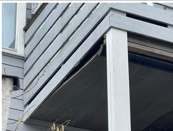
Bilde nr. 15 Ny overflatebehandling av balkonger og utbedring av platene under balkonger.
