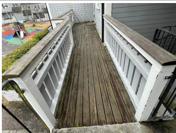
Bilde nr. 17 Nytt gulv på svalganger.
