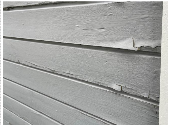
Bilde nr. 4 Utskifting av kledning med råte på småhus og forbedre avslutning mot bakken, ny overflatebehandling enkelte steder.
