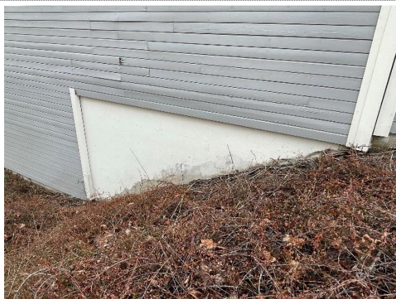
Bilde nr. 5 Utskifting av kledning med råte på småhus og forbedre avslutning mot bakken, ny overflatebehandling enkelte steder.
