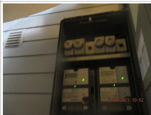
Bilde nr. 40 Undersentraler som ikke er oppgradert må fornyes de neste 10 år.
