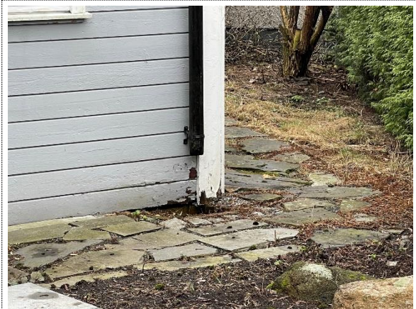
Bilde nr. 6 Utskifting av kledning med råte på småhus og forbedre avslutning mot bakken, ny overflatebehandling enkelte steder.
