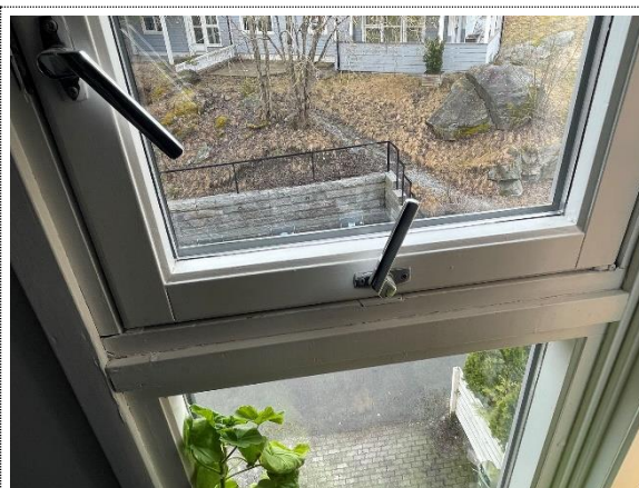
Bilde nr. 8 Utskifting av vinduer, balkongdører og inngangsdører.
